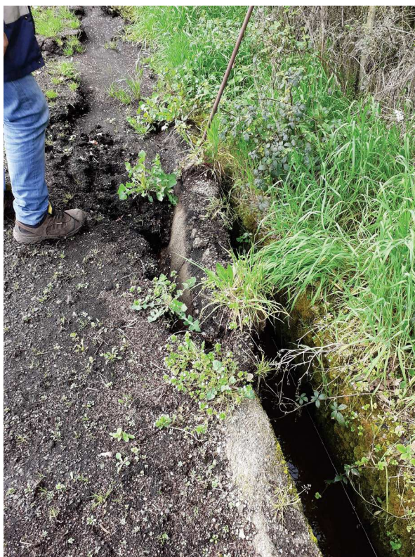
Caniveau de recueil des eaux de ruissellement de la plateforme de compostage détérioré
